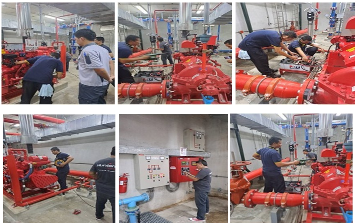
ภาพที่ 4-37 การตรวจสอบระบบ Fire Pump
