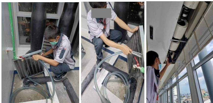
ภาพที่ 4-34 ทำความสะอาดระบบปรับอากาศ
