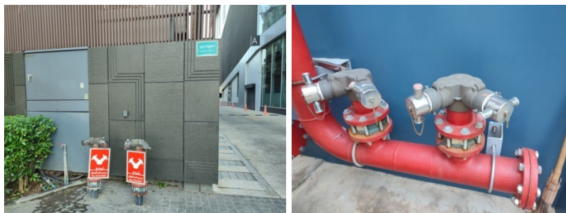
ภาพที่ 4-19 หัวรับน้ำดับเพลิงจากภายนอกอาคาร A และอาคาร B
