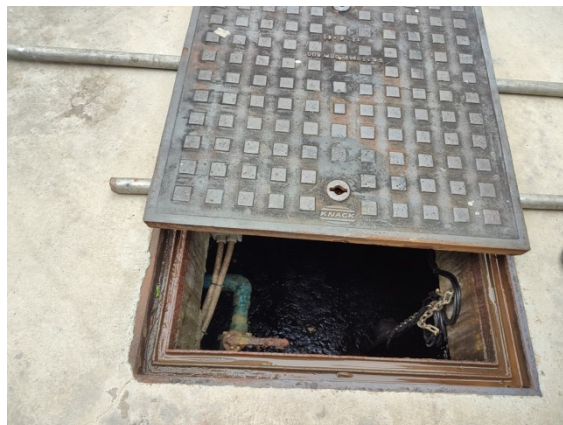
ภาพที่ 4-40 ดูตะกอนที่บ่อเก็บตะกอนของระบบบำบัดน้ำเสีย
