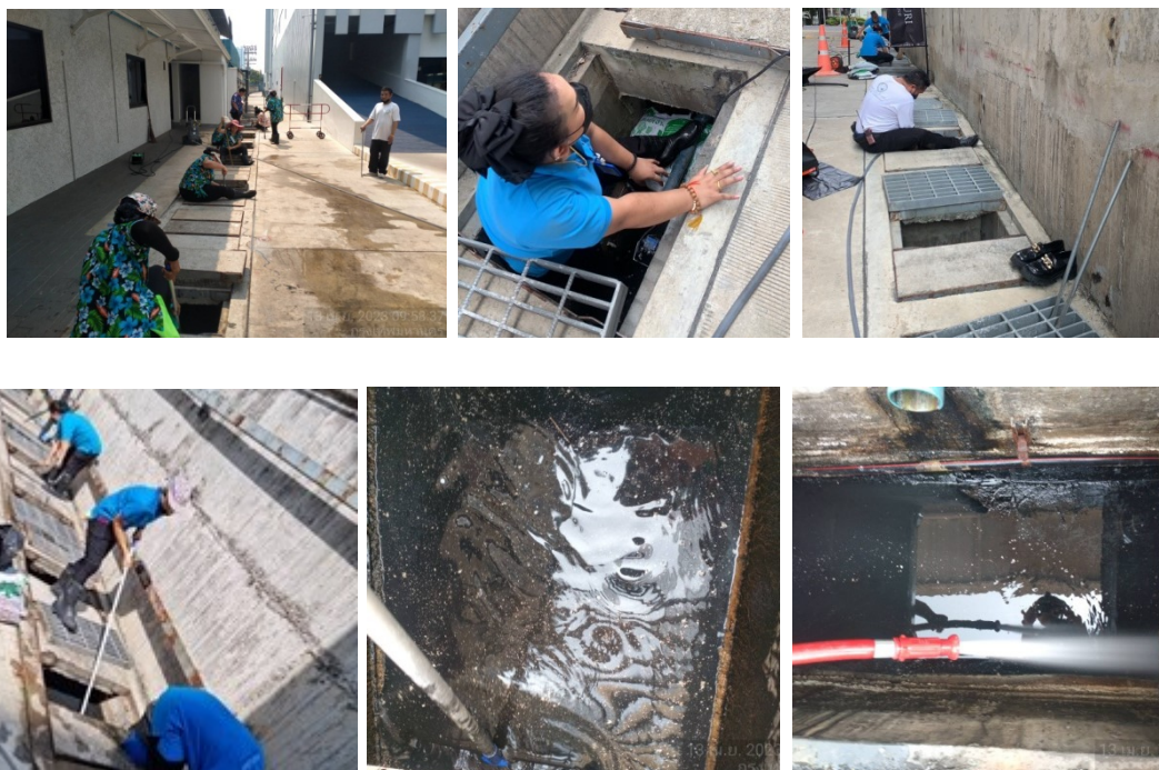
ภาพที่ 4-35 ดำเนินทำความสะอาดท่อระบายน้ำ
